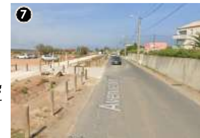
Cheminement piéton le long du parking du Front de Mer
