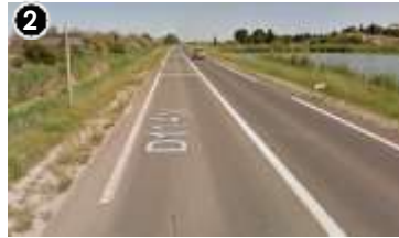
2 Après la RD116 : un axe de largeur convenable, offrant une bonne visibilité et favorisant les prises de vitesse... sur une section de type « péri urbaine »
