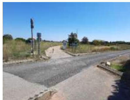
Voie Verte au départ de Vic la Gardiole : un point de départ déconnecté du parking situé au croisement de la RD114 et de l'av de la Croix de Mission (entrée EST de Vic)
