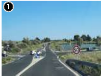
1 Carrefour RD114/RD116 : une circulation relativement modérée mais des vitesses significatives sur l'axe principal, rendant inconfortables les mouvements tournants et traversants (RD116)
