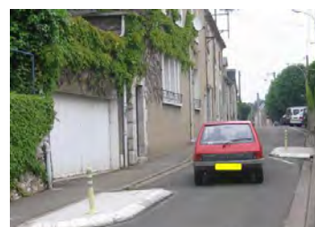
Dispositifs permettant de ralentir la vitesse des usagers en zone urbaine (coussin ralentisseur, « dos d'âne », chicane)
