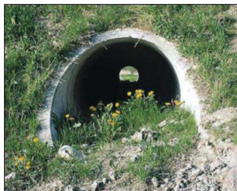
Figure 104 : Exemple de passage inférieur à petite faune, type buse
