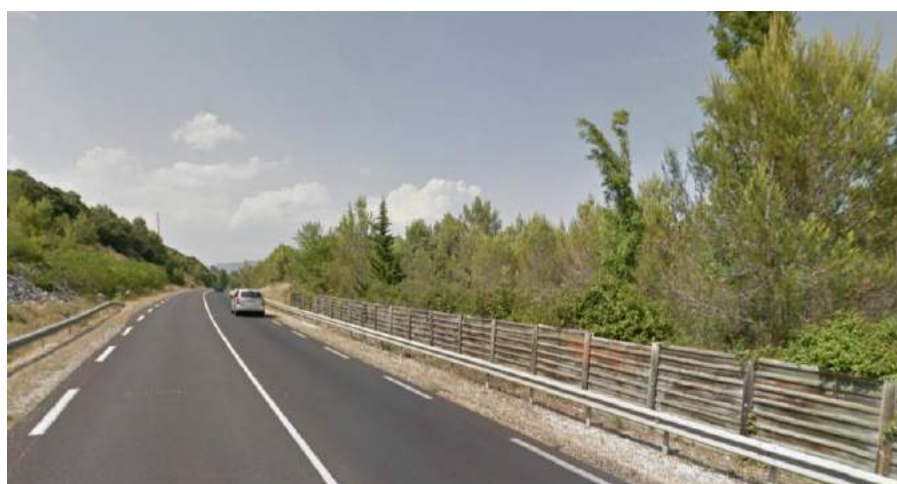
Figure 134 : Protection phonique existante sur la déviation de Saint-Gély
