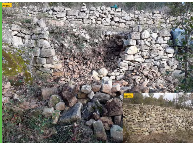
Remise en état de murettes en pierres sèches
