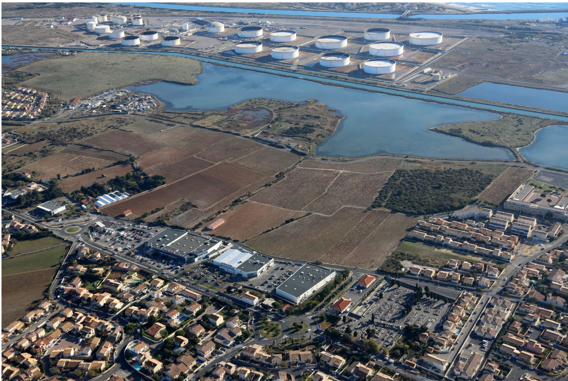
Vue aérienne partielle du site depuis la mer - Photo Ville de Frontignan-La-Peyrade
