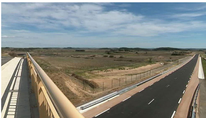
RD612 Déviation de Puisserguier
