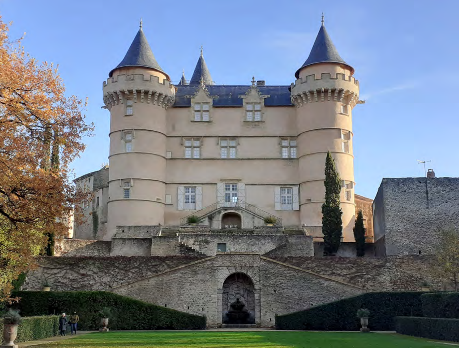
Château de Margon, restauration des enduits © F. Mazeran DEPT34
