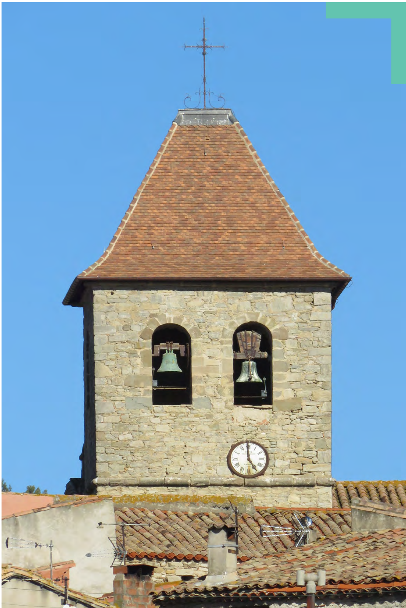
Toiture restaurée du clocher de l'église Saint-Laurent d'Azillanet © F. Mazeran DEPT34
