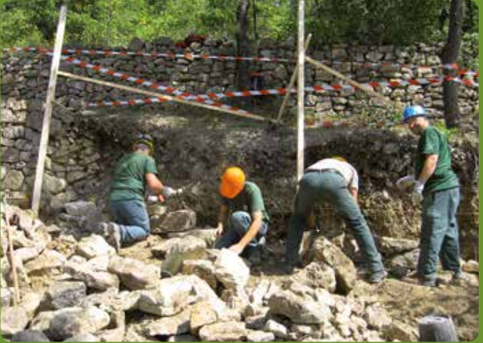
LES RANDO-PISTEURS DU DÉPARTEMENT RÉALISENT UN MUR EN PIERRES SÈCHES SUR UN SENTIER DE L'HÉRAULT
