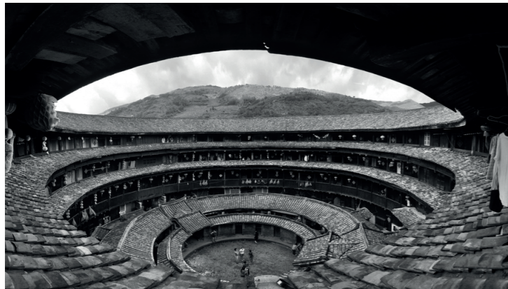
Architectures traditionnelles Tulou du Fujian (Chine)
