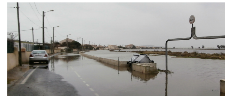
Inondation sur Frontignan Plage côté étang d'Ingril
